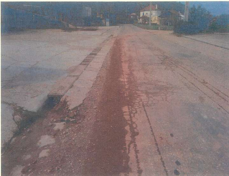
Foto 9: Rua Nossa Senhora da Piedade e Rua São Miguel, na localidade de Igreja Velha - Mau estado de conservação da via com acumulação de areias junto às bermas e na própria via oriundos das zonas de exploração, dentro do perímetro habitacional.
