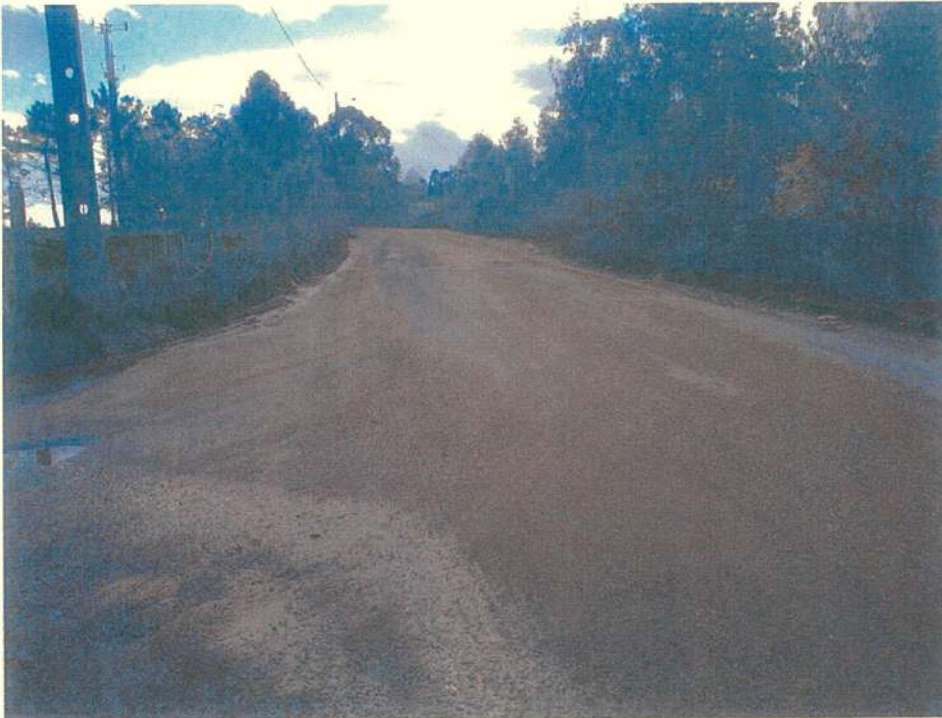
Foto 13: Localidade do Barracão – Acumulação de areias dentro da localidade junto às bermas e detritos nas vias originados pela exploração
