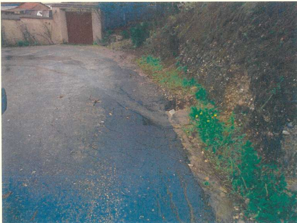
Foto 2: Rua do Brejinho – Lugar de Igreja Velha – Mau estado de conservação do pavimento dentro da localidade de Igreja Velha.
