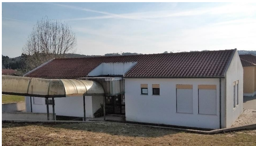
Figura 6 – Cobertura em Telha Cerâmica – Existente
