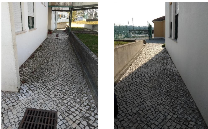
Figura 4 e 5 – Calçada existente a remover
