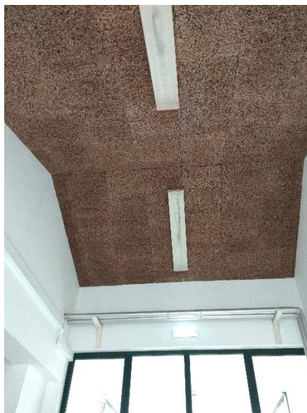
Figura 8 – Tecto do Átrio de Entrada a substituir
